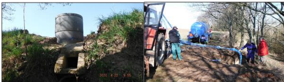
Obr. 30 Šachtice 44-5 – odkrytá a navýšená šachtice (vlevo), čištění hydročištěčem (vpravo)
