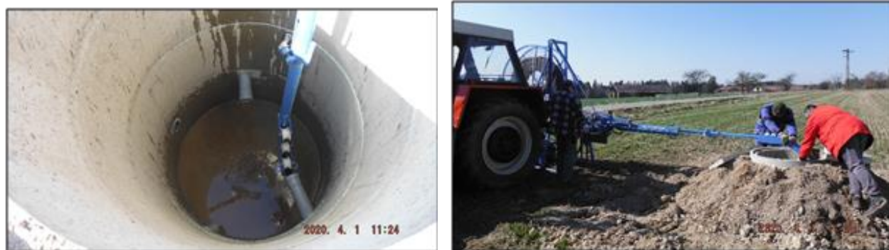
Obr. 25 Šachtice 1-2 – čištění drénů hydročističem. Snímek vlevo – pohled do šachtice (vlevo nahoře přítok ochranného drénu, přímo nahoře přítok svodného drénu, vlevo dole odtok ochranného drénu, vpravo dole odtok svodného drénu). Snímek vpravo – provádění údržby/čištění drénů.
