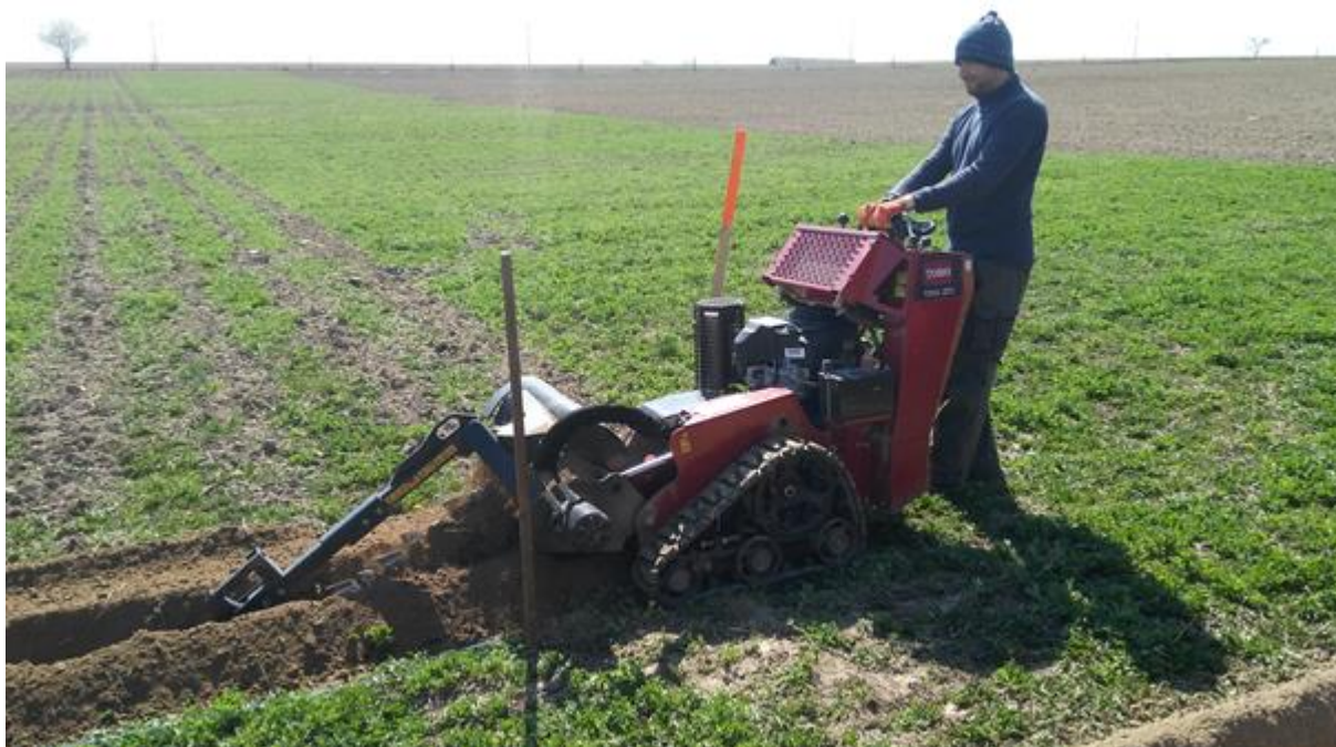
Obr. 36 Příprava pro pokládku textilie rýhovačem TORO
