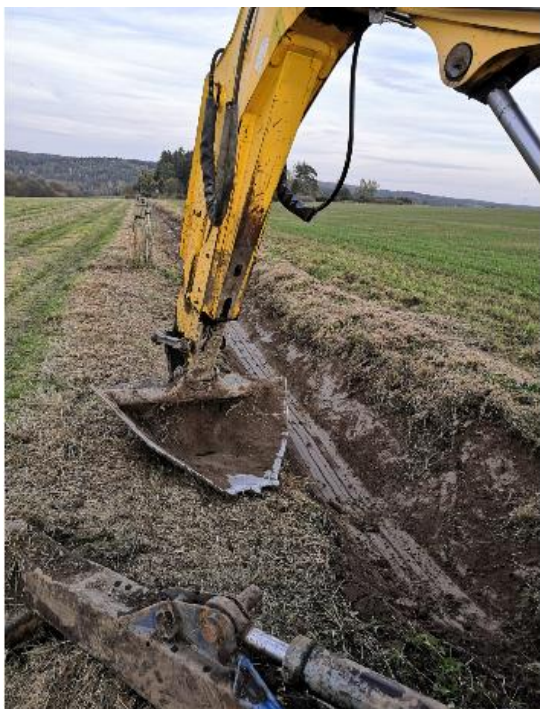
Obr. 17 Pročišťování odvodňovacího kanálu v severní části území
