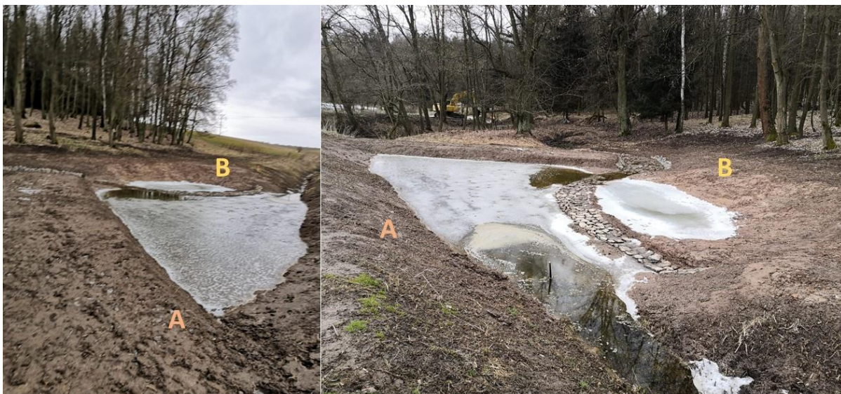
Obr. 21 Vzdouvací tůň (A) a mokřadní tůň (B) naplněné vodu. Mokřadní tůň bude posléze osázena vodními rostlinami.
