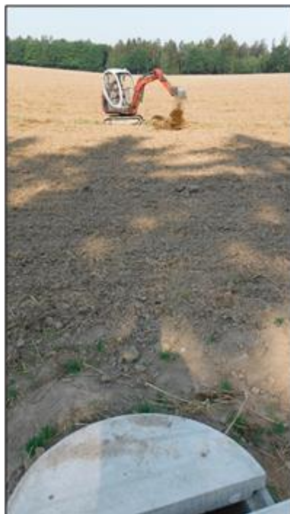
Obr. 28 Šachtice 14 – instalace šachtice a následné čištění drenů v délce 50 m+70 m
