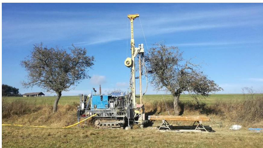
Obr. 13 Vrtání geologických monitorovacích vrtů na zemědělské půdě v říjnu 2021
