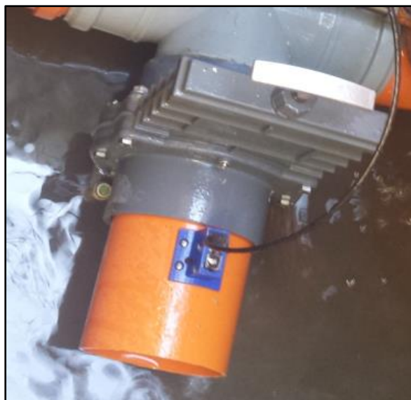
Obr. 32 U šachtic byly instalovány offline dataloggery (s přípravou napojení na monitorovací síť)
