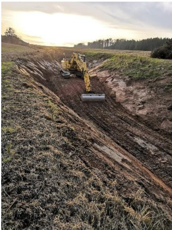
Obr. 19 Výstavba a konečná podoba malých retenčních nádrží v povodí Karlův luh
