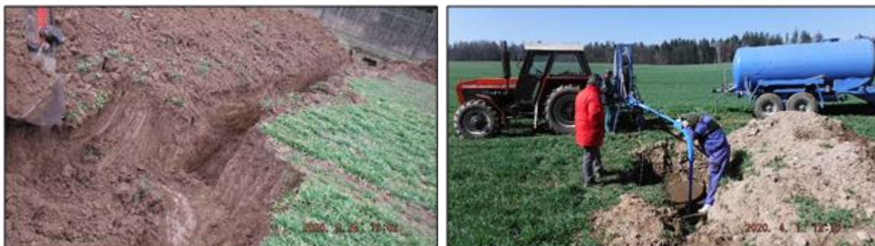
Obr. 27 Šachtice 14-1 – odkrytí (vlevo) a čištění stávající šachtice hydročištěčem (vpravo)
