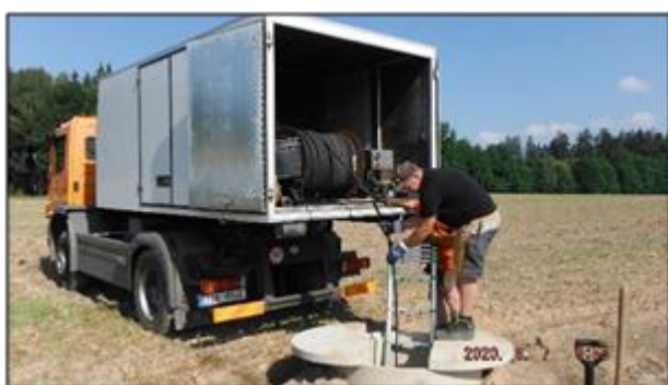
Obr. 33 Šachtice 14 – instalace šachtice a následné čištění drenů v délce 50 - 70 m
