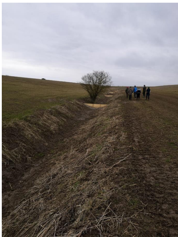
Obr. 21 Části kaskádového svejlu – svejl naplněný vodou, svodný kanál s přehrázkami. Dále bude okolo svejlu a kanálu vytvořen luční pás zpevňující povrch půdy.
