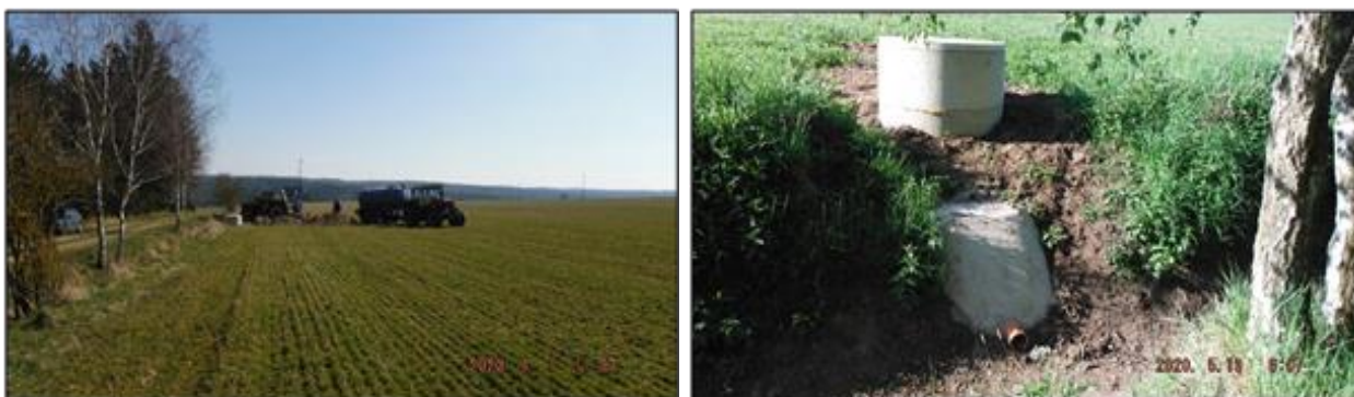
Obr. 29 Šachtice 1-1 – čištění svodného drénu v délce 113 m pomocí hydročističe (vlevo), kompletní vystrojení šachtice s vyústěním do HOZ (vpravo)
