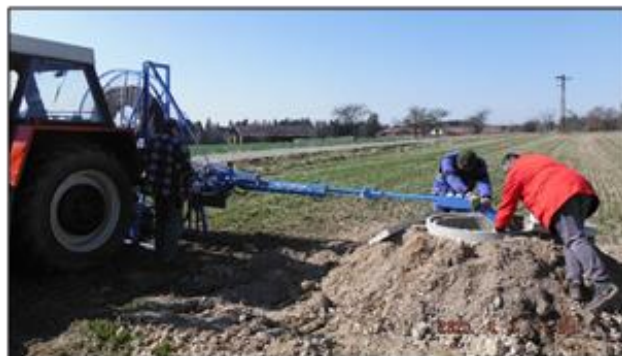
Obr. 30 Šachtice 1-2 – čištění drénů hydročističem. Snímek vlevo – pohled do šachtice (vlevo nahoře přítok ochranného drénu, přímo nahoře přítok svodného drénu, vlevo dole odtok ochranného drénu, vpravo dole odtok svodného drénu). Snímek vpravo – provádění údržby/čištění drénů.
