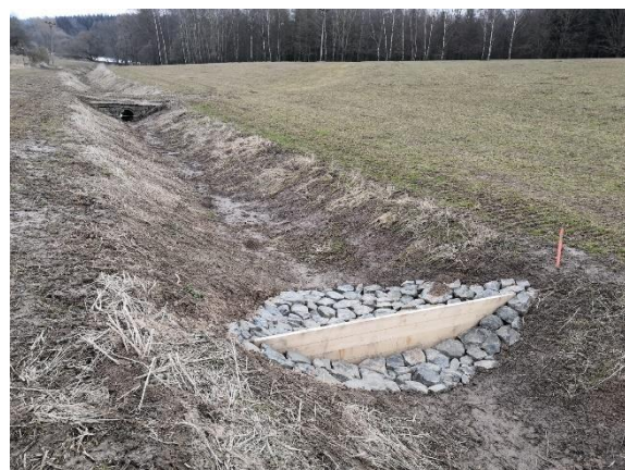
Obr. 21 Části kaskádového svejlu – svejl naplněný vodou, svodný kanál s přehrázkami. Dále bude okolo svejlu a kanálu vytvořen luční pás zpevňující povrch půdy.
