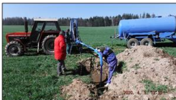
Obr. 32 Šachtice 14-1 – odkrytí (vlevo) a čištění stávající šachtice hydročističem (vpravo)
