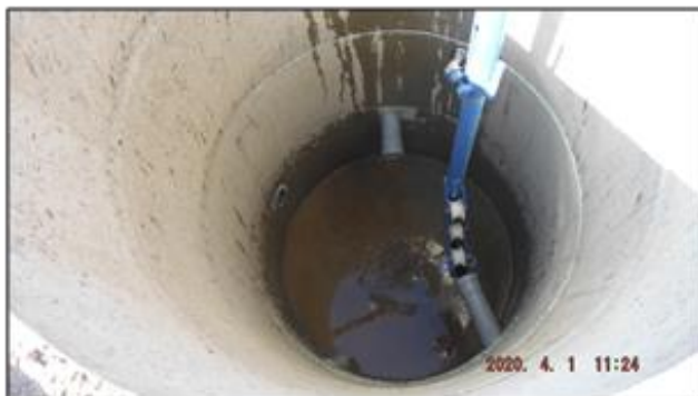
Obr. 30 Šachtice 1-2 – čištění drénů hydročističem. Snímek vlevo – pohled do šachtice (vlevo nahoře přítok ochranného drénu, přímo nahoře přítok svodného drénu, vlevo dole odtok ochranného drénu, vpravo dole odtok svodného drénu). Snímek vpravo – provádění údržby/čištění drénů.
