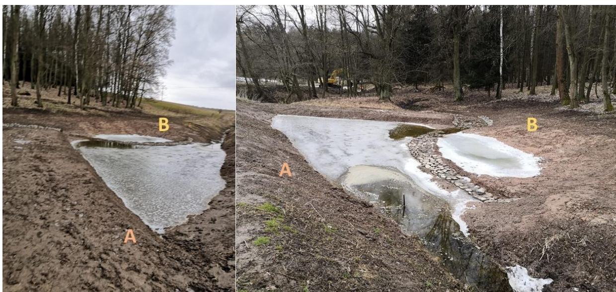
Obr. 22 Vzdouvací tůň (A) a mokřadní tůň (B) naplněné vodou. Mokřadní tůň bude posléze osázena vodními rostlinami.
