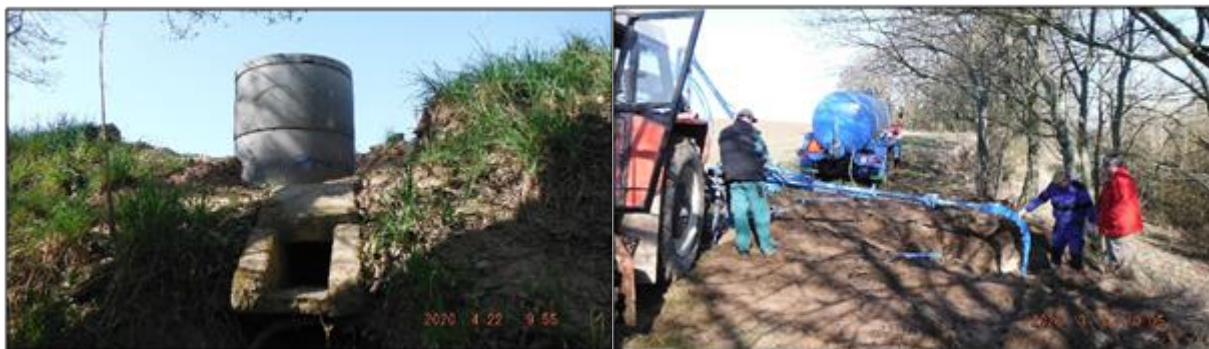
Obr. 35 Šachtice 44-5 – odkrytá a navýšená šachtice (vlevo), čištění hydročističem (vpravo)
