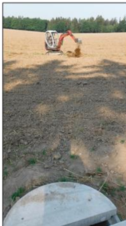
Obr. 33 Šachtice 14 – instalace šachtice a následné čištění drenů v délce 50 - 70 m
