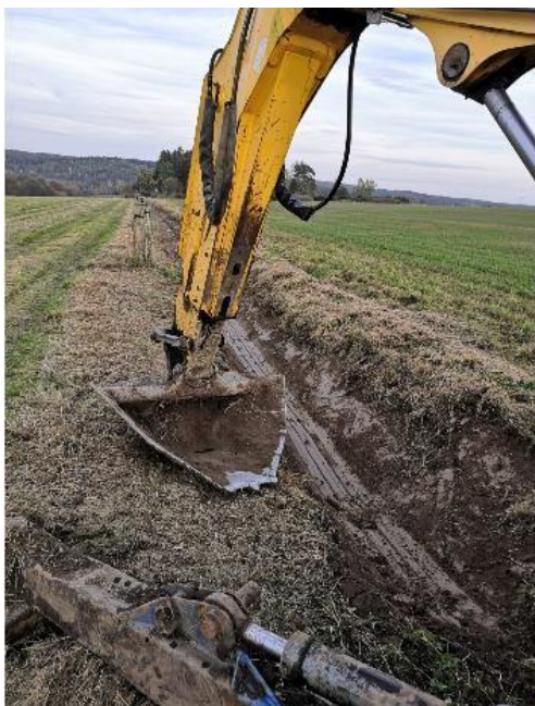
Obr. 20 Pročišťování odvodňovacího kanálu v severní části území
